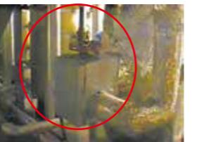
汎用品は放熱が確認できますが、ヒートキップは立体成形の為、放熱を抑えられ蒸気流量を削減できます！
